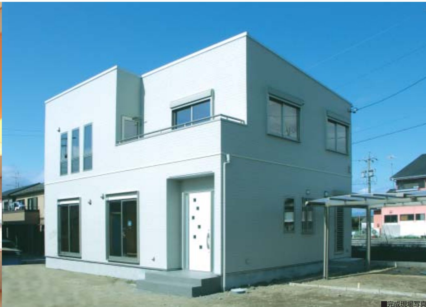
■完成現場写真
